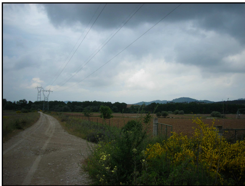
Fotografia 1 – Aspecto Geral do Terreno entre os apoios AP9 e AP10
